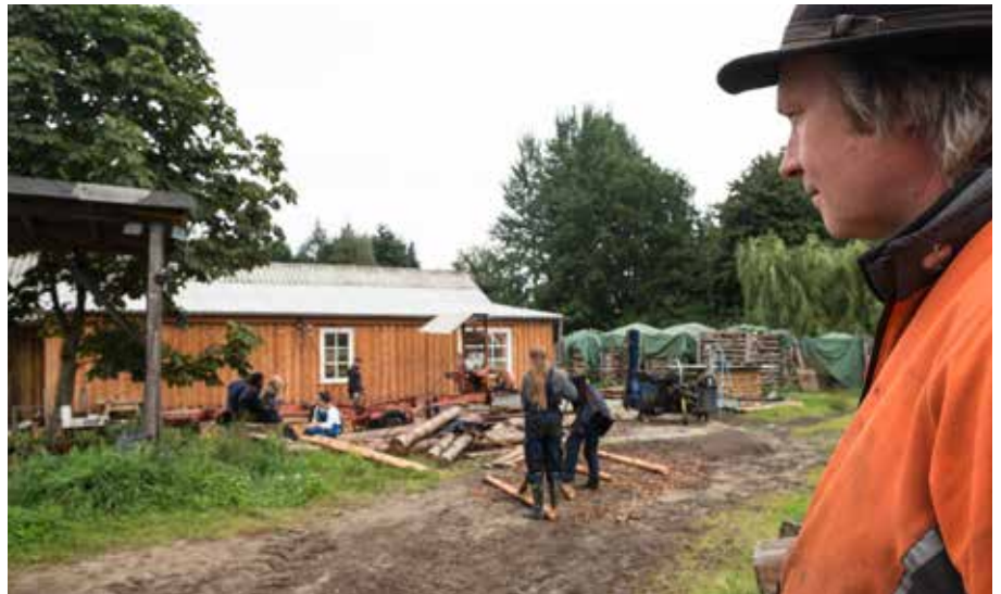
Vom Weg aus ist der neue Anbau zu sehen. Eine Schulklasse entrindet die Stämme für das Sägewerk.
